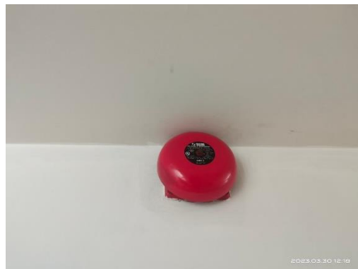
รูปที่ 13 สัญญาณเตือนเพลิงไหม้
