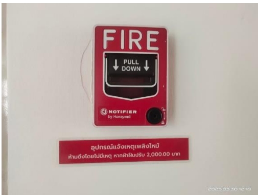
รูปที่ 13 สัญญาณเตือนเพลิงไหม้
